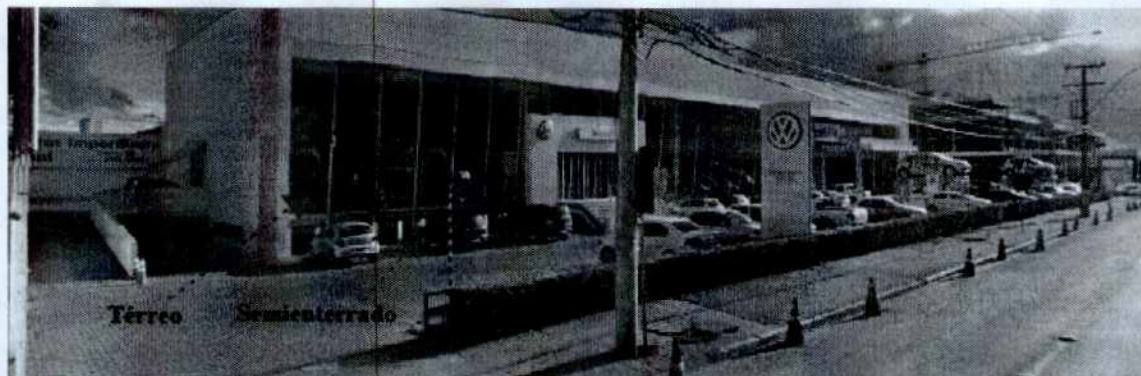
Figura 17: Empreendimento vizinho, cuja implantação também se deu em lotes remembrados, e ao contrário do Praça Capital manteve o perfil natural do terreno, possibilitando a visualização da fração aflorada. Fonte: Google Earth / Data provável: Abril/2015
