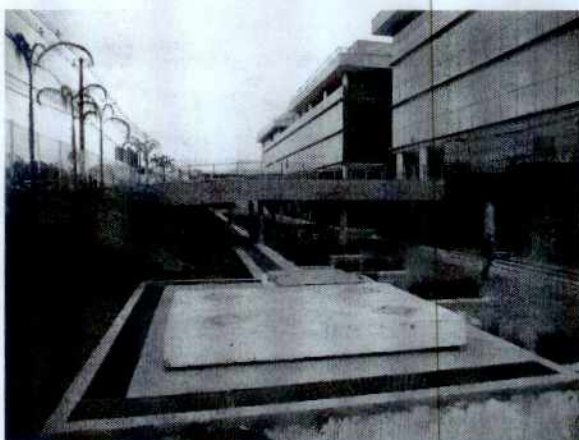
Figura 5: Vista dos taludes e área de galeria com lojas voltadas para via do SLA no "Semienterrado". Fonte: Assessoria Técnica - Vistoria em 2/6/2016
