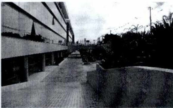
Figura 8: Acesso de veículos pela fachada principal. Fonte: Assessoria Técnica - Vistoria em 2/6/2016.
