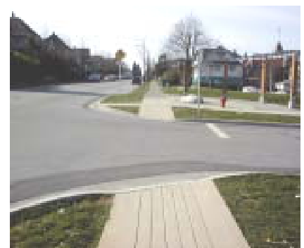
Figure 3-9 : Exemples de rainures dans le trottoir.
